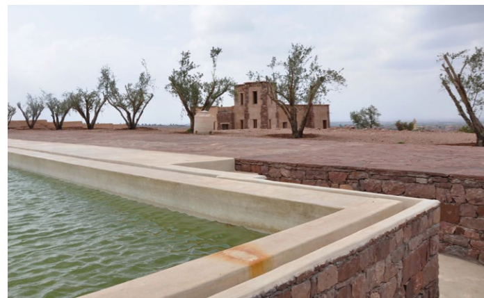
Dieses Wasserbecken in der Provinz Haouz ist mit feinem Tadelakt, einem traditionellen Material aus Kalk, Marmorpulver und Zement verputzt.
