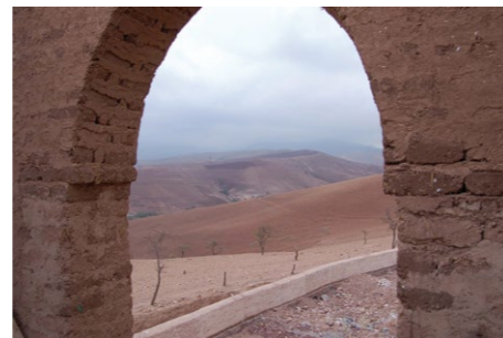
Der Neubau der Ecolodge Wiri-Zen bei Marrakesch ist aus Stampflehm und Lehmziegeln gebaut.
